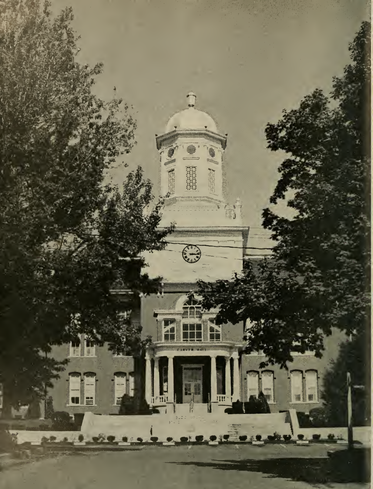
CARVER HALL (Erected 1867)
